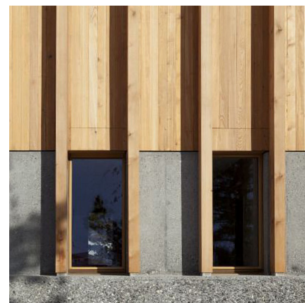
SOCKELVÅNING I BETONG
